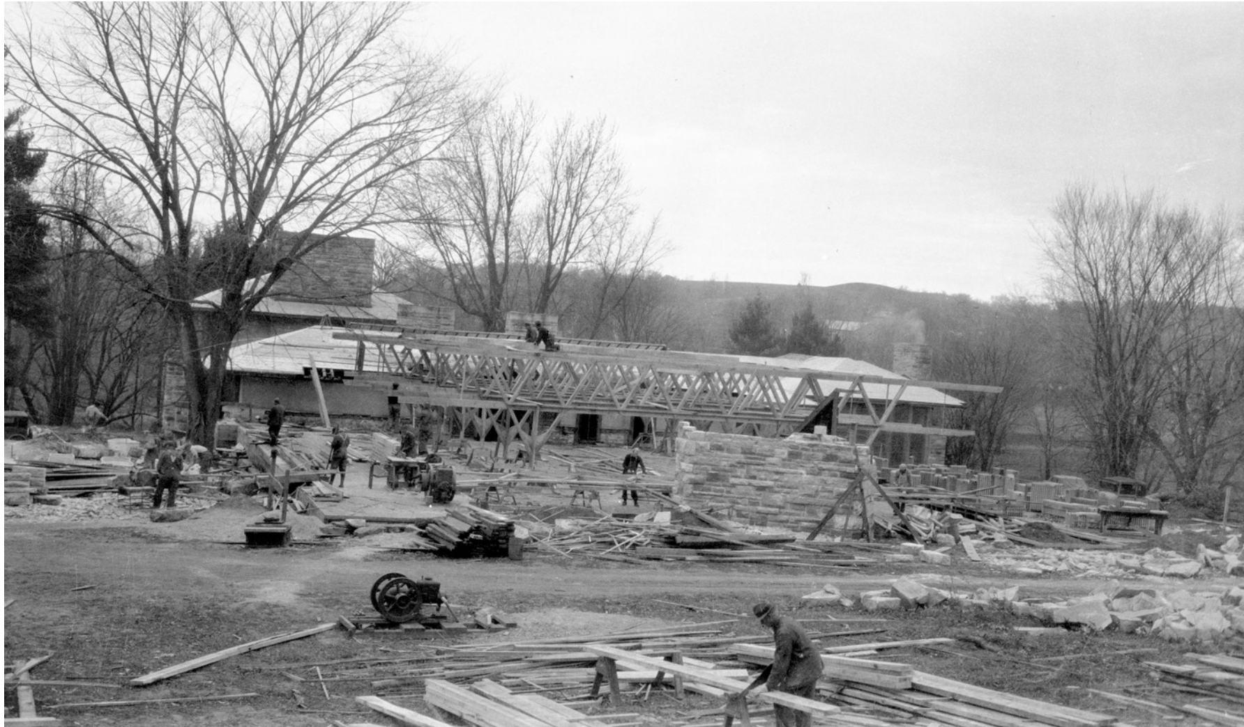
Construcción nuevo taller, 1932 Foto cortesía del Taliesin Preservation.
